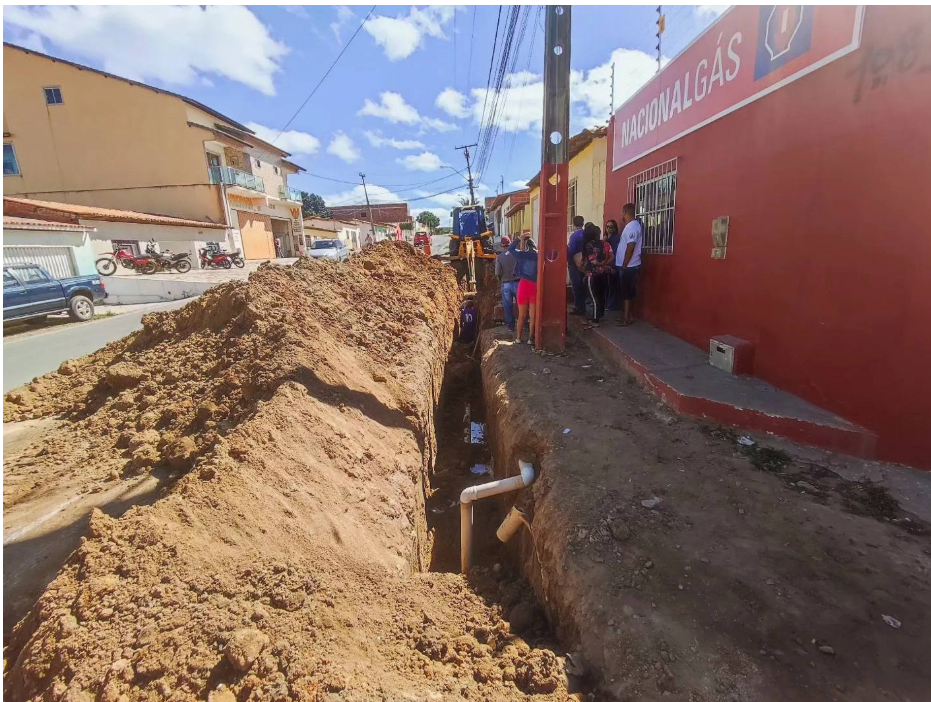
Obras de implantação da extensão da rede de esgotamento sanitário da Avenida Peixoto Júnior, no bairro Primavera.
